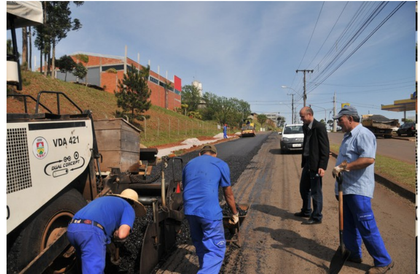
Quatro frentes de trabalho para fazer consertos nas ruas de Erechim
