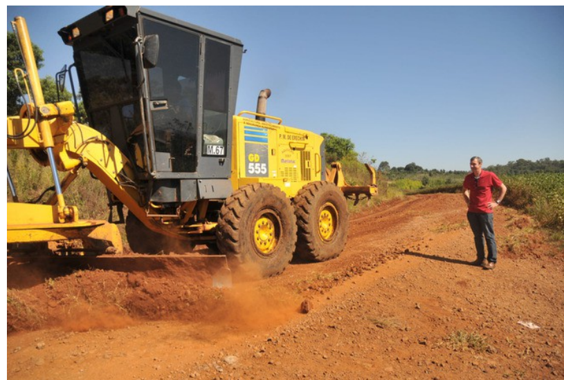
Conserto e Melhorias em Estradas
