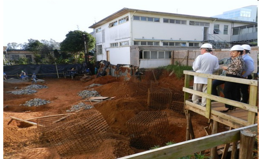
Retomada das obras da nova Unidade em Alta Complexidade em Oncologia – UNACON
