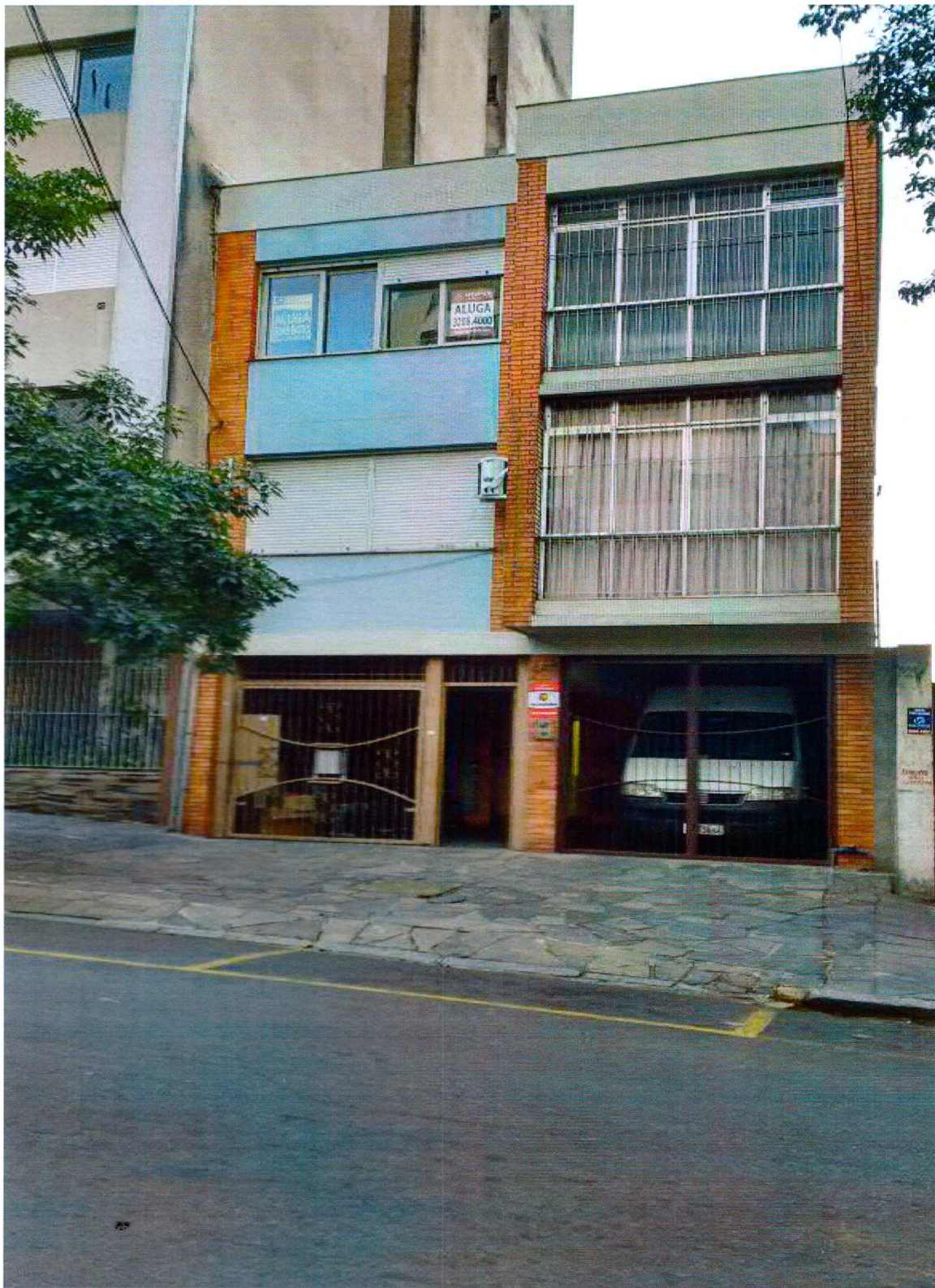
FACHADA - FRENTE DA CASA DE APOIO
