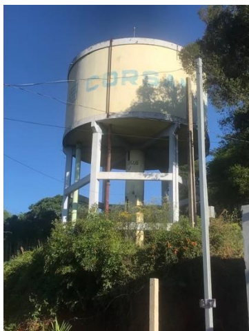
Figura 23 – Reservatório Elevado – Travessa 2 (500 m3)
