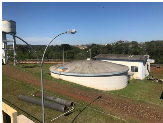
Figura 19 – Reservatório Apoiado – ETA 2 (1.000 m 3 )
