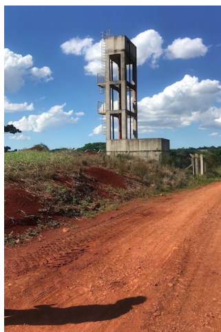
Figura 9 – Sistema de transição – Adutora Rio do Cravo
