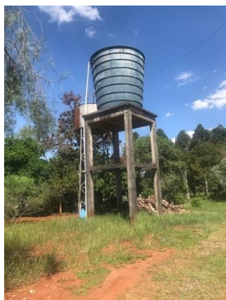
Figura 29 – Reservatório Elevado – Jaguaretê (20 m3)
