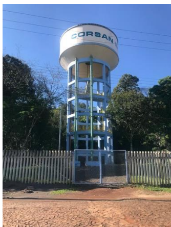
Figura 25 – Reservatório Elevado – Rua Alvar Izidro Coffy 2 (500 m3)
