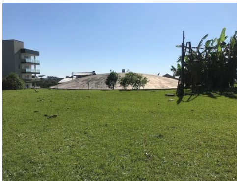
Figura 16 – Reservatório enterrado – ETA 1 (2.000 m 3 )
