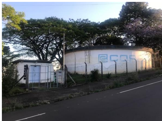
Figura 21 – Reservatório Apoiado – Rua Polônia (1.500 m3)
