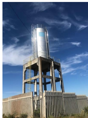
Figura 28 – Reservatório Elevado – Bem Morar Erechim (200 m3)
