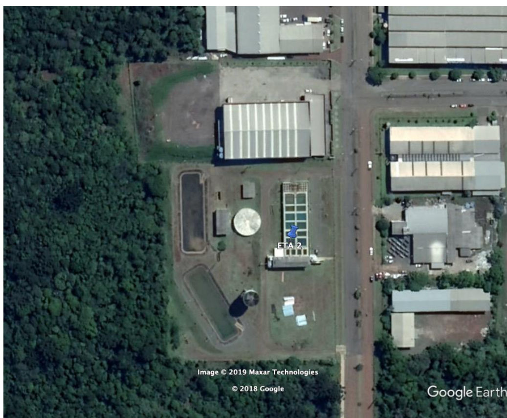
Figura 13 – Vista geral da ETA 2
