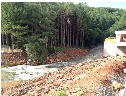
Figura 8 – Captação Rio do Cravo
