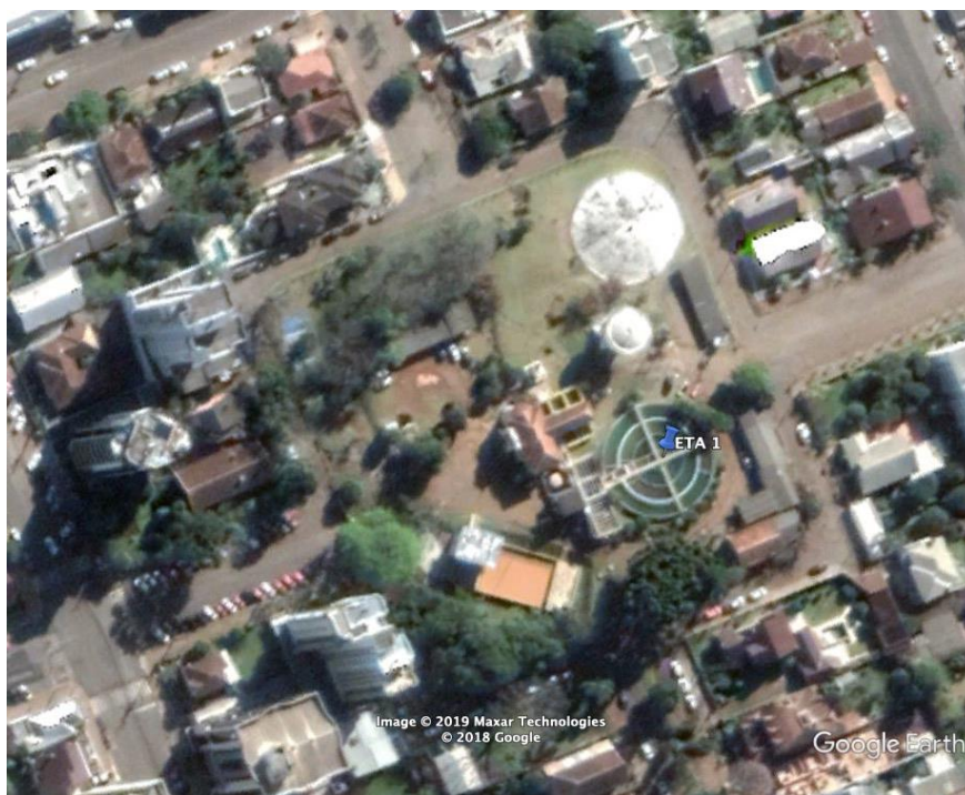
Figura 11 – Vista geral da ETA 1
