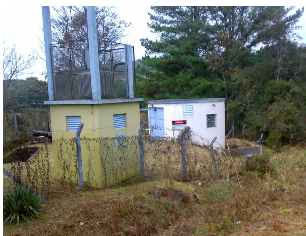
Figura 67: Elevatória de água bruta do Rio Campo.
