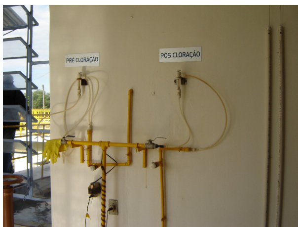
Figura 50: Dispositivo de aplicação do cloro gás.
