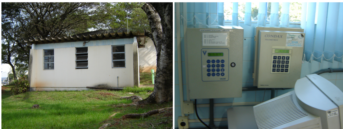
Figura 97: Antena de rádio frequência e Centro de controle.
