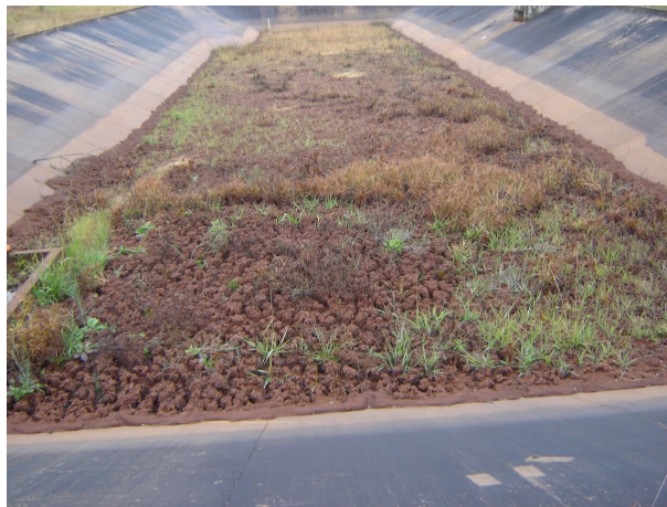
Figura 57: Lagoa de decantação operando como leito de secagem do lodo.
