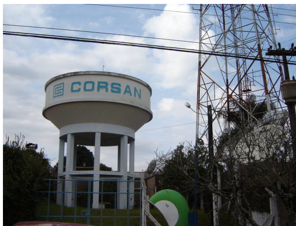
Figura 92: Reservatório elevado de 250 m 3 da Rua Soledade (RBS).
