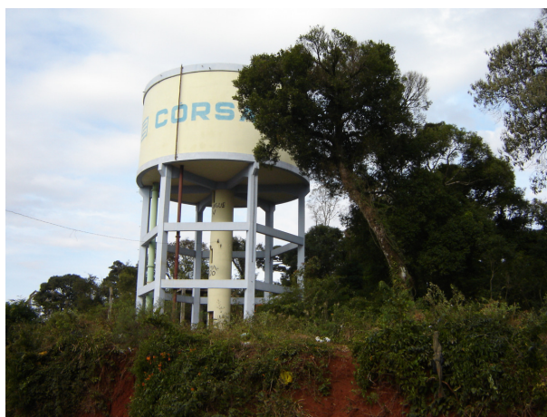
Figura 93: Reservatório elevado de 500 m 3 da Rua Travessa 2.
