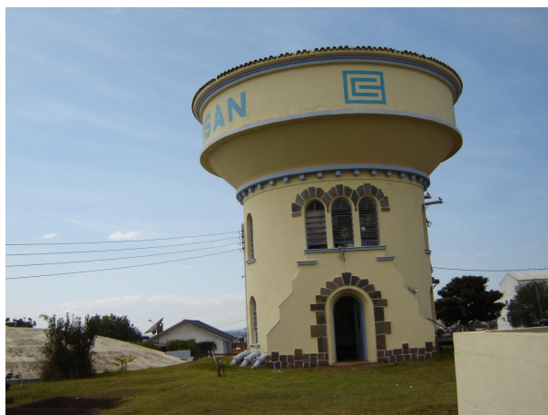
Figura 88: Reserv. elevado de 250 m 3 e apoiado de 1.000 m 3 na ETA 2.
