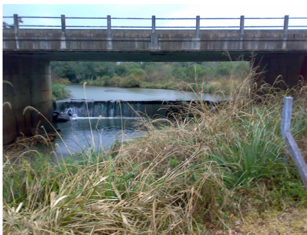
Figura 27: Barragem do reservatório formado pelo rio Campo.
