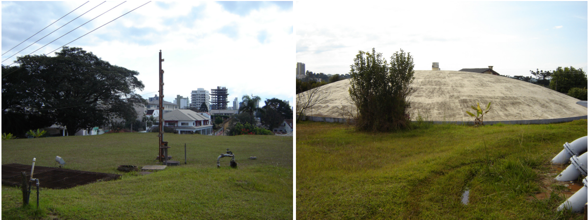
Figura 89: Reservatórios enterrado de 1.500 m 3 e de 2.000 m 3 na ETA 1.
