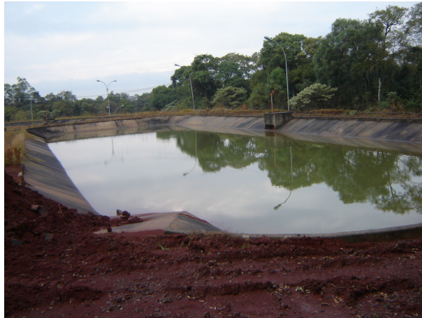
Figura 56: Lagoa de decantação do lodo da ETA 2.
