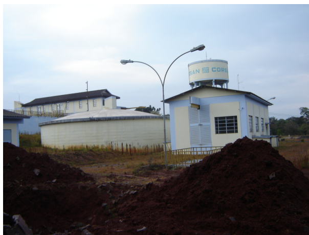
Figura 87: Reserv. elevado de 250 m 3 e apoiado de 1.000 m 3 na ETA 2.
