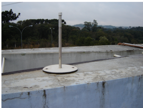
Figura 52: Calha Parshall e régua de medição do nível.
