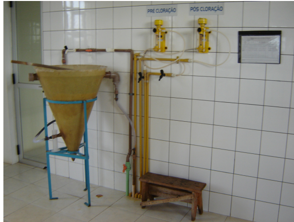
Figura 64: Dosador de Flúor e cloro gás.
