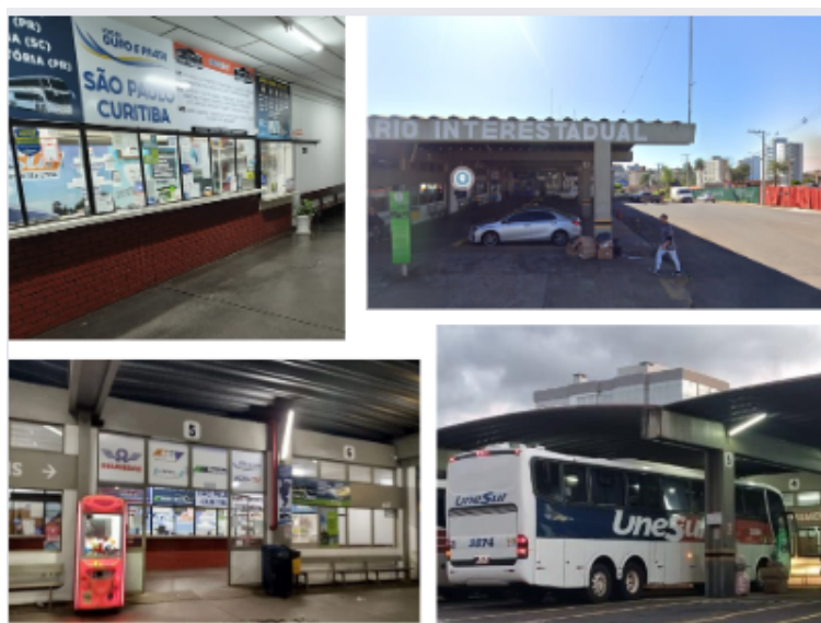
Figura 15: Terminal Rodoviário de Erechim – espaços intermunicipal e interestadual
