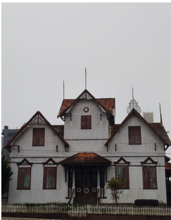
Figura 5: O prédio do Castelinho, abrigou durante os anos de 1912 a 1915, a Comissão de Terras do estado do Rio Grande do Sul, responsável pelo planejamento urbano de Erechim, incluindo o projeto de ruas, avenidas e loteamentos urbanos e rurais
