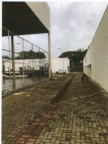
IMAGEM: Ponto a ser instalado conjunto no Bairro Progresso
