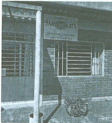
Foto da fachada do local inspecionado
