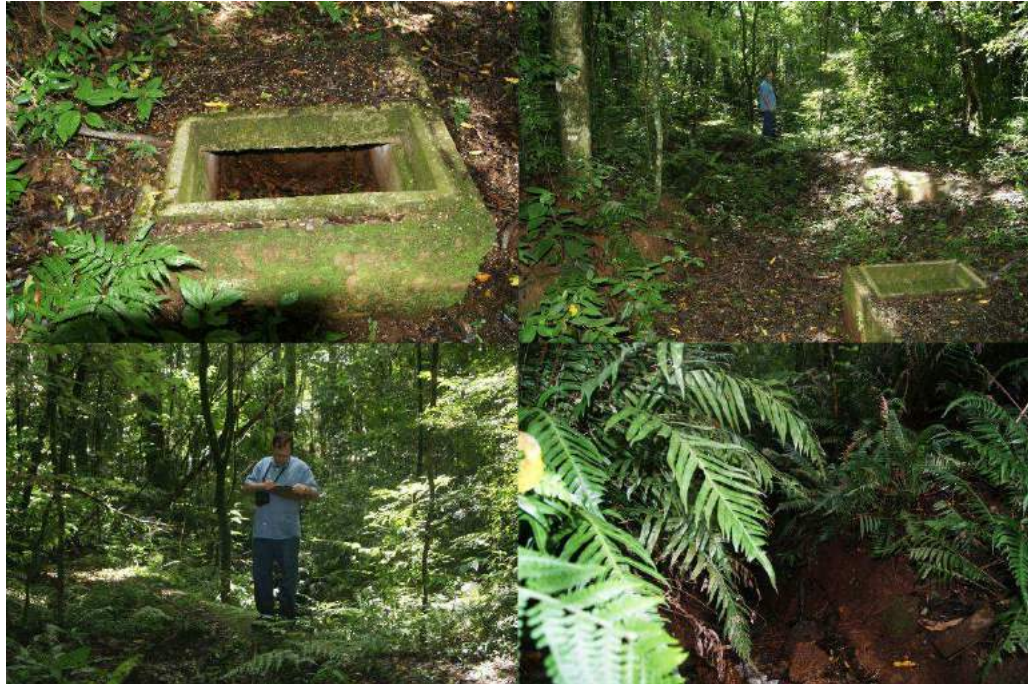
Figura 45 - Tubulação de Esgoto Sanitário Inserida no Parque Natural Municipal Longines Malinowski, Erechim – RS.
