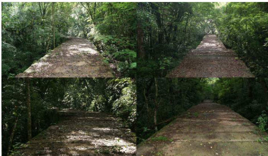
Figura 42 - Galeria de Esgoto Sanitário Inserida no Parque Natural Municipal Longines Malinowski, Erechim – RS.
