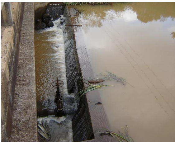
Figura 33: Duas tubulações de \varnothing 200 mm que vão ao poço de sucção da elevatória da barragem do rio Campo.
