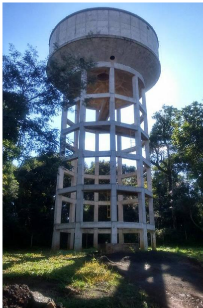
Figura 98: Reservatório elevado de 500 m 3 (em construção).
