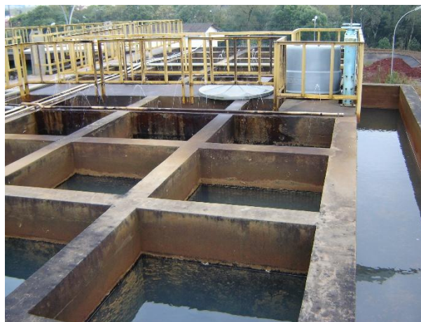
Figura 57: Floculadores hidráulicos.
