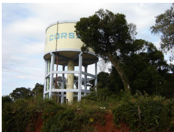
Figura 96: Reservatório elevado de 500 m 3 da Rua Travessa 2.
