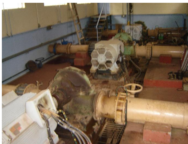
Figura 73: Elevatória de água bruta para ETA 1.
