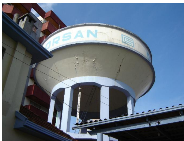
Figura 93: Reservatório elevado de 150 m 3 da Rua Portugal.
