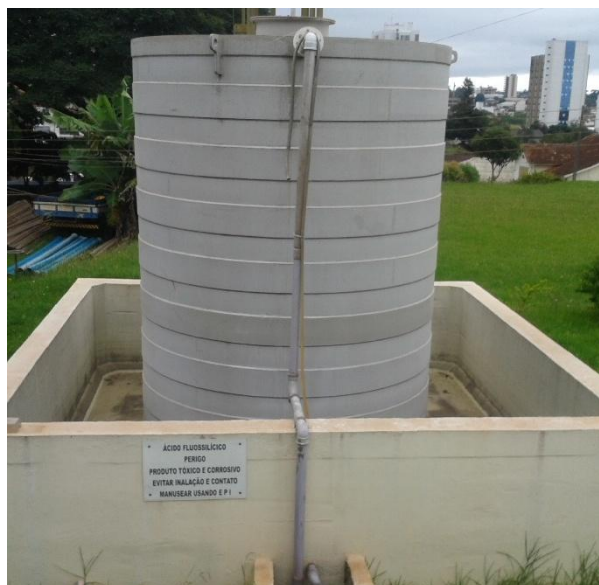
Figura 53: Depósito de Ácido Fluossilícico.
