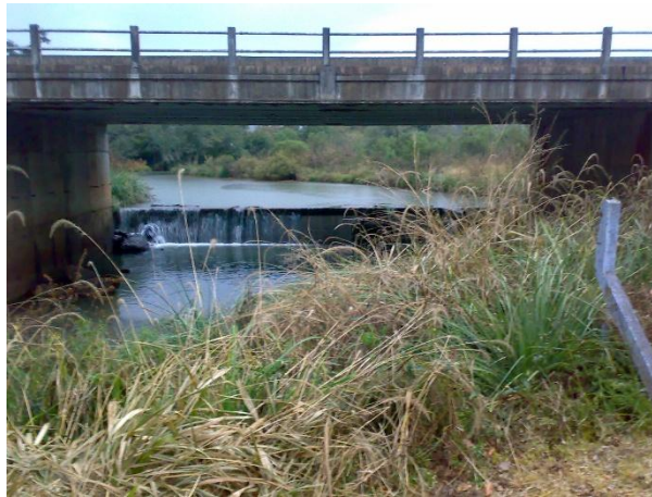
Figura 26: Barragem do reservatório formado pelo rio Campo.
