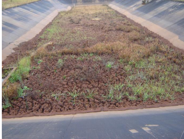
Figura 61: Lagoa de decantação operando como leito de secagem do lodo.
