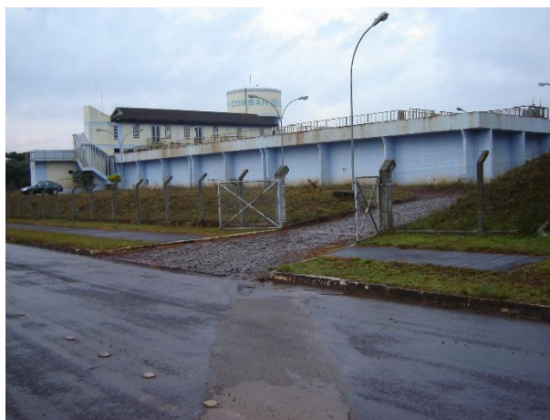
Figura 55: ETA 2 no bairro Industrial.
