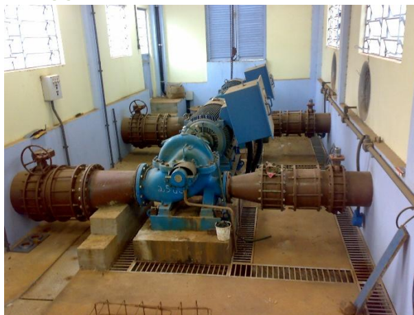
Figura 75: Elevatória de água bruta para ETA 2.
