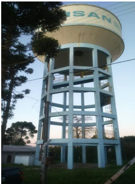
Figura 97: Reservatório elevado de 500 m 3 .
