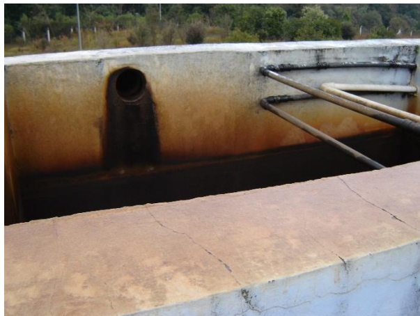
Figura 63: Chegada da água da lagoa na entrada da Calha Parshall.
