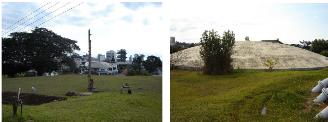
Figura 92: Reservatórios enterrado de 1.500 m 3 e apoiado de 2.000 m 3 na ETA 1.
