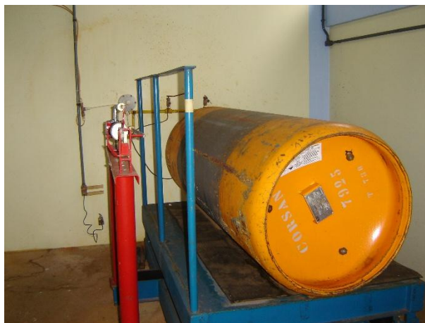
Figura 69: Cilindro de 900 kg de cloro.
