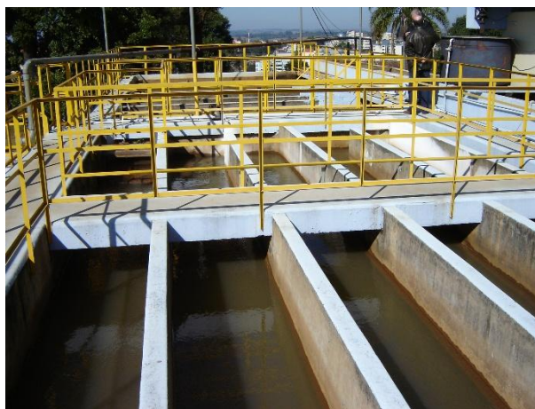
Figura 40: Floculadores verticais de fluxo horizontal.
