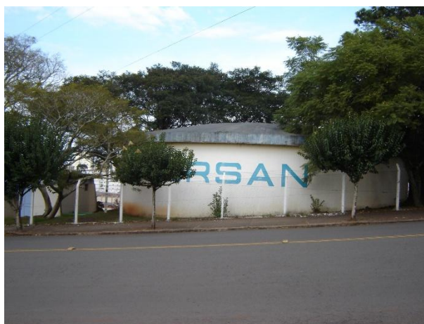
Figura 94: Reservatório apoiado de 1.500 m 3 da Rua Polônia.
