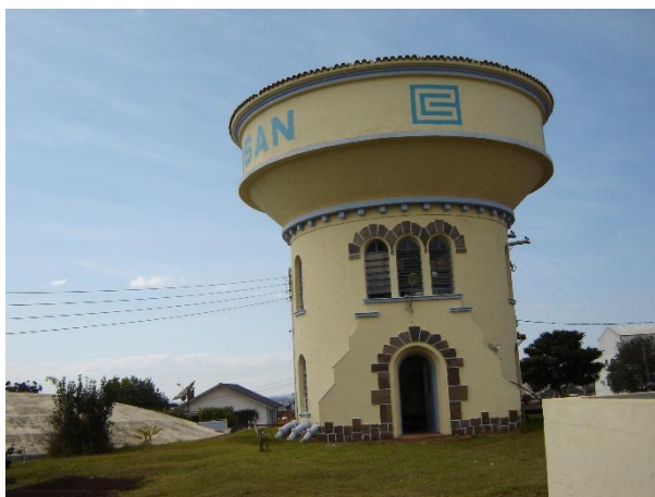
Figura 91: Reserv. elevado de 250 m 3 e apoiado de 2.000 m 3 na ETA 2.
