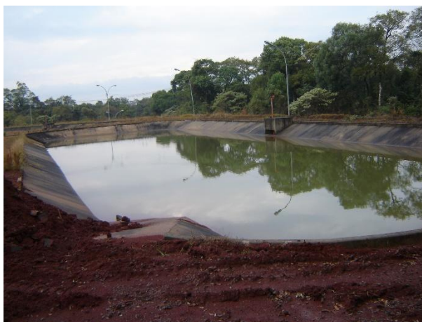
Figura 60: Lagoa de decantação do lodo da ETA 2.
