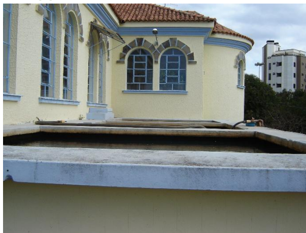
Figura 42: Filtros da ETA 1 de fluxo descendente.
