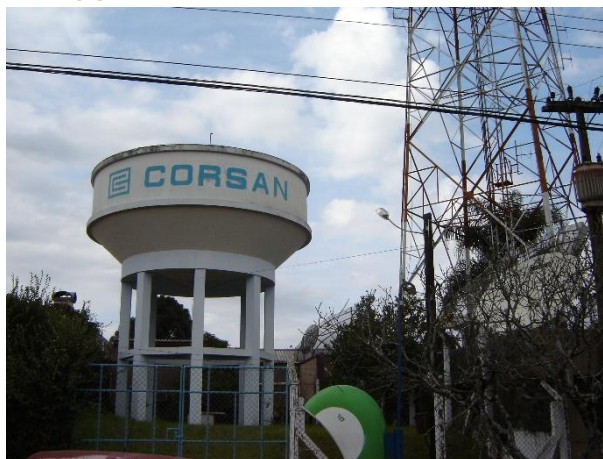
Figura 95: Reservatório elevado de 250 m 3 da Rua Soledade (RBS).
