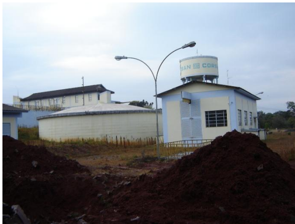
Figura 90: Reservatório elevado de 500 m 3 e apoiado de 1.000 m 3 na ETA 2.
