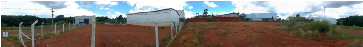
Figura 3: Vista ao redor do local de instalação.
