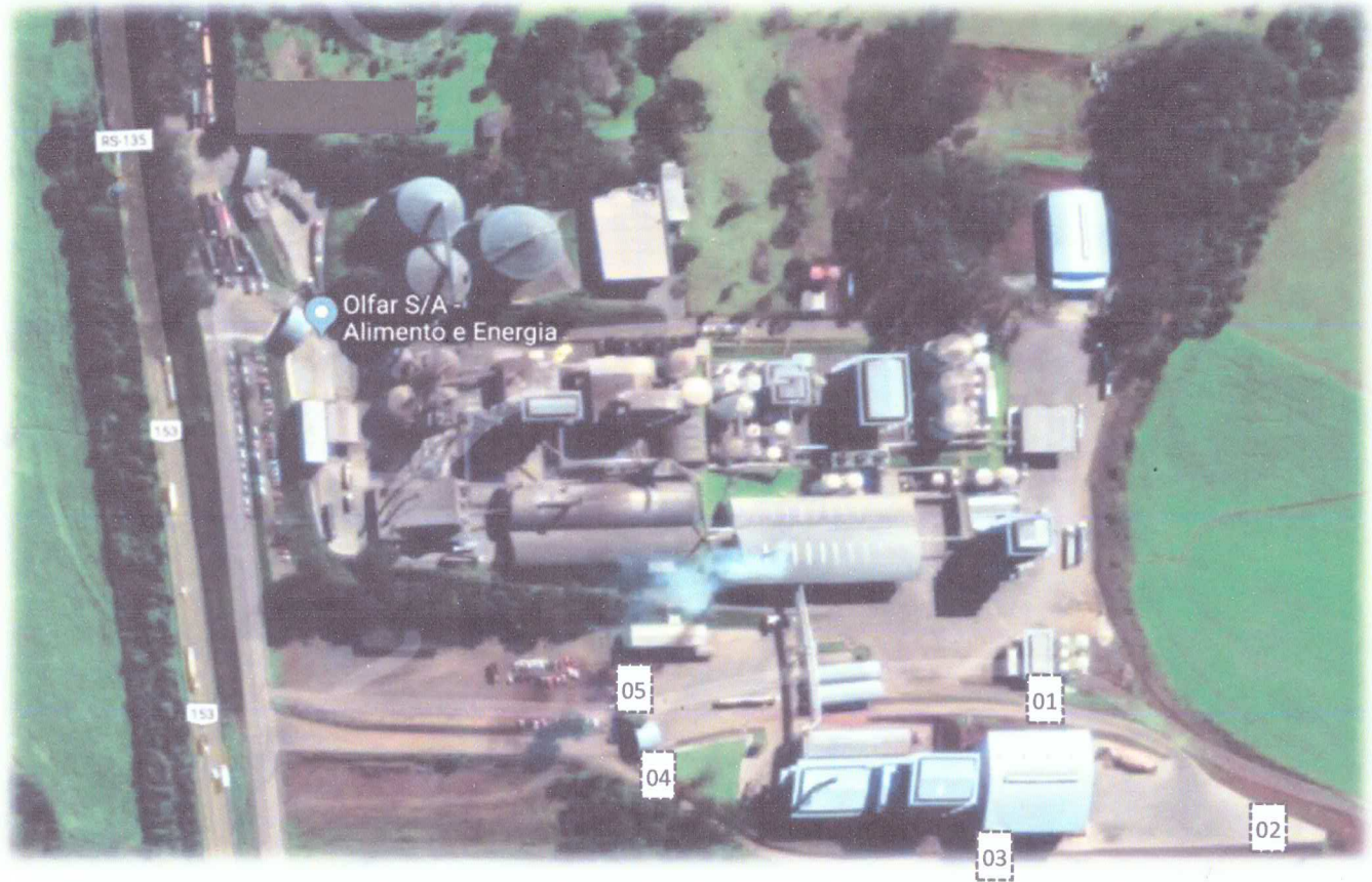
Figura 3: vista aérea planta industrial, situando a localização dos 5 pontos de medição
