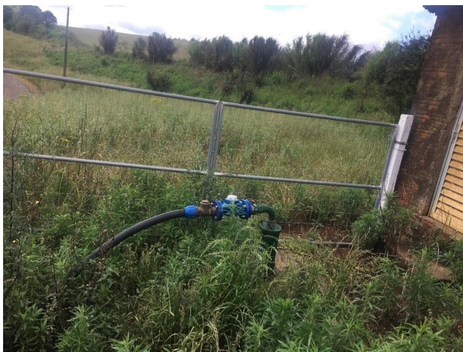
Figura 10 - Poço 01 (Distrito de Capo-Erê).
