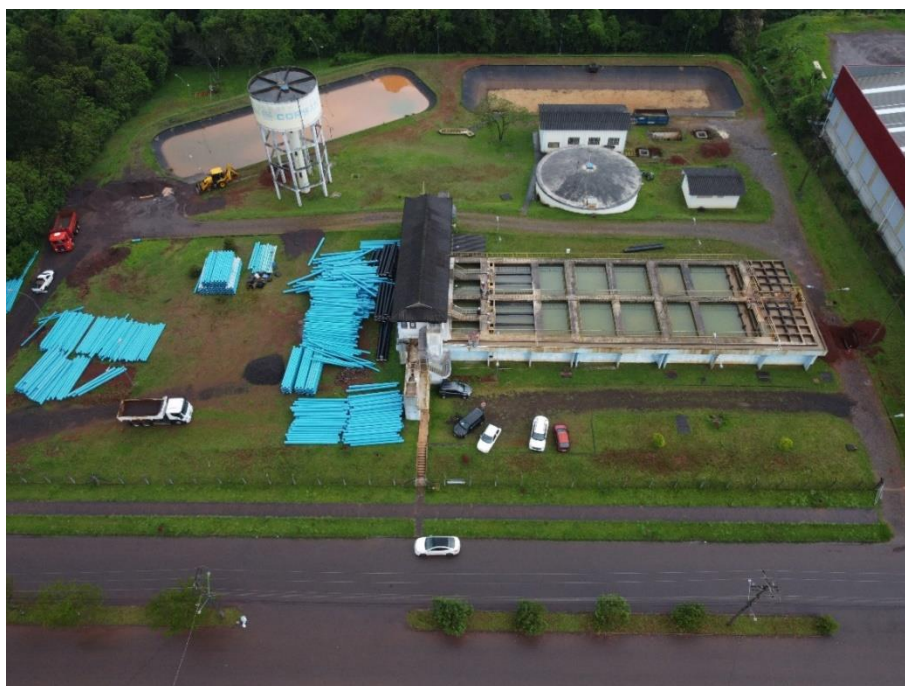
Figura 19 - Estação de Tratamento de Água ETA 2.
