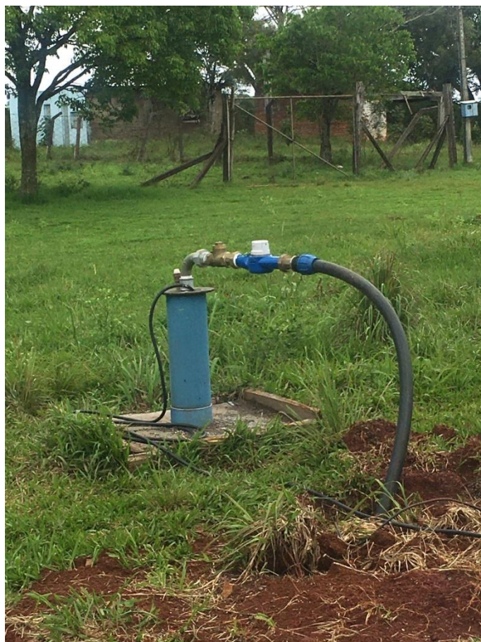
Figura 11 - Poço 02 (Distrito de Capo-Erê).
