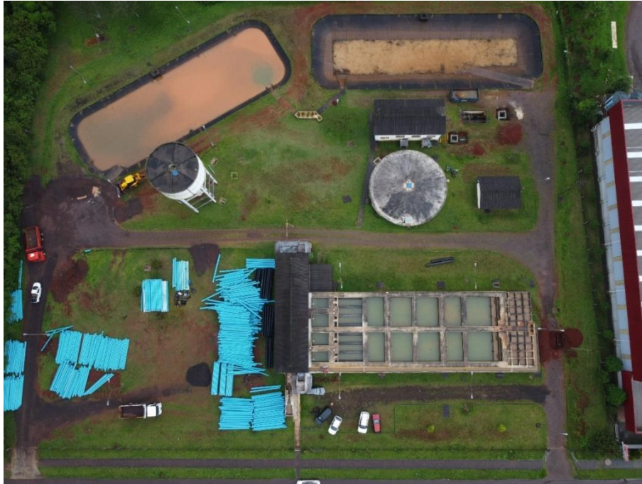
Figura 20 - Estação de Tratamento de Água ETA 2.
