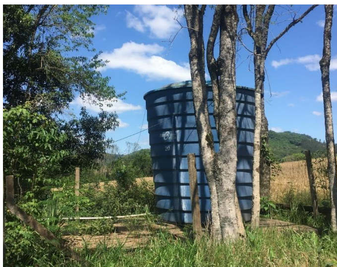
Figura 42 - RAP Distrito de Jaguaretê.
