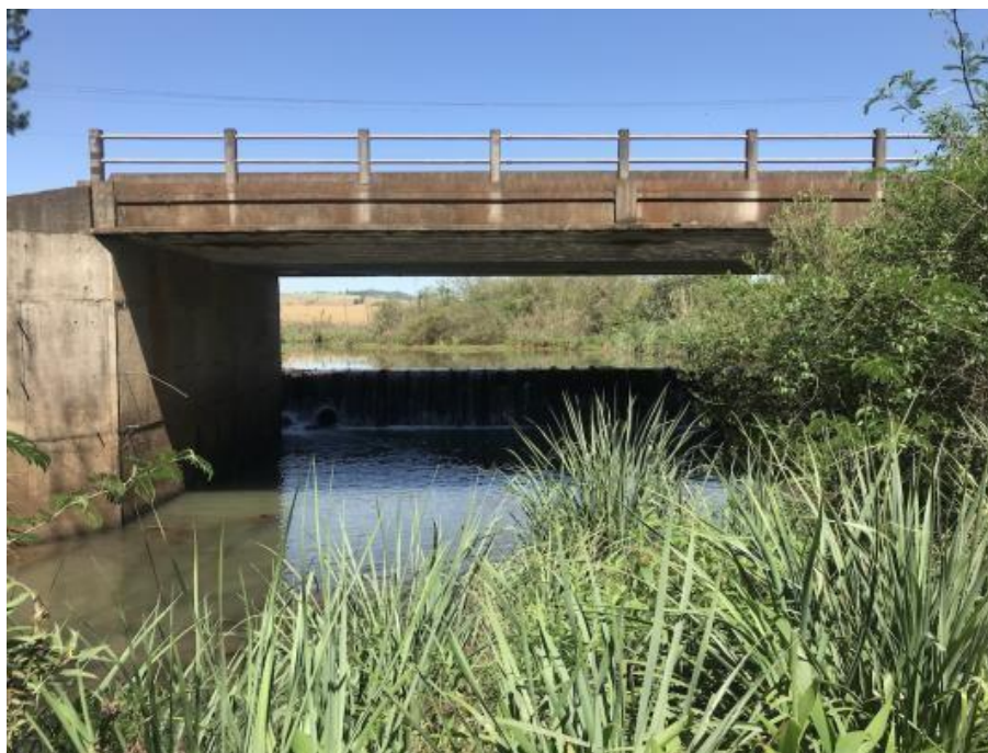
Figura 5 - Barragem (Rio do Campo).
