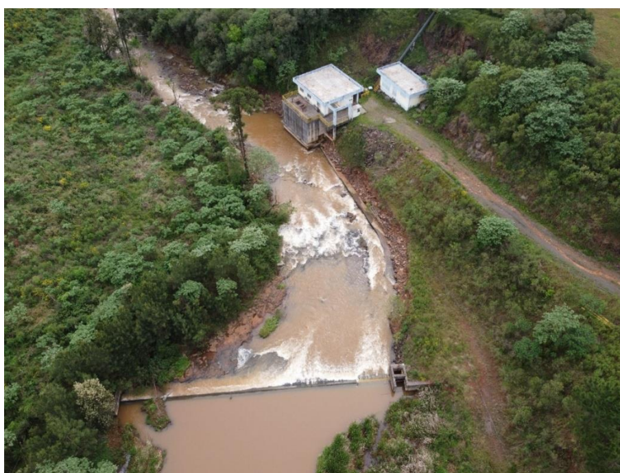
Figura 4 - Barragem (Rio do Cravo).
