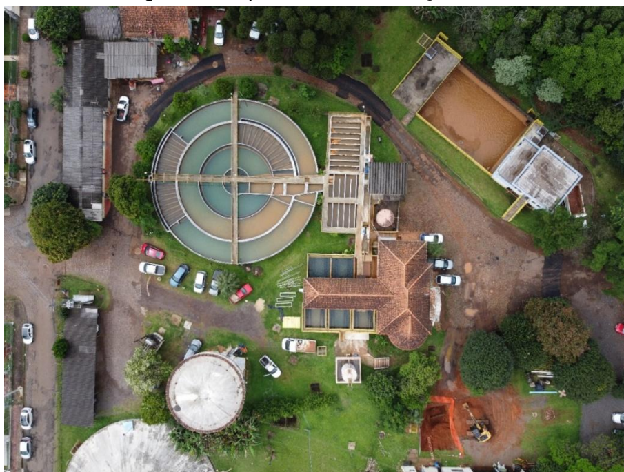
Figura 22 - Estação de Tratamento de Água ETA 1 2/2
