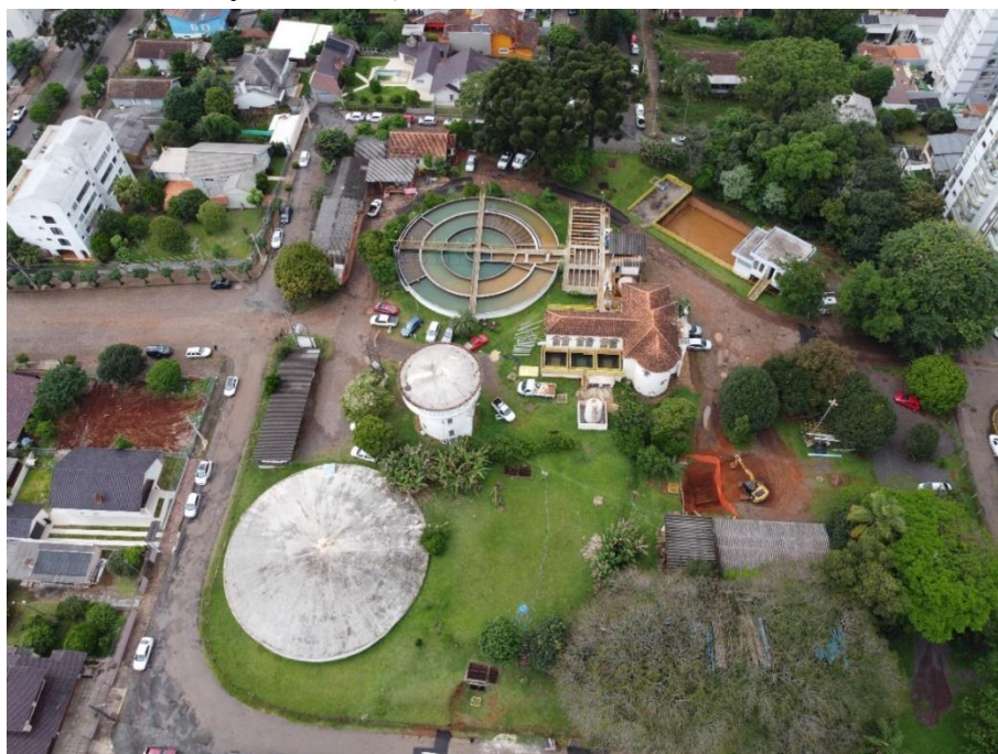
Figura 21 - Estação de Tratamento de Água ETA 1 1/2.
