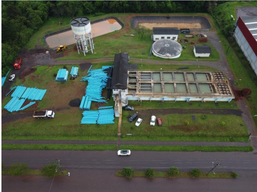
Figura 23 - Estação de Tratamento de Água ETA 2 (1/2).
