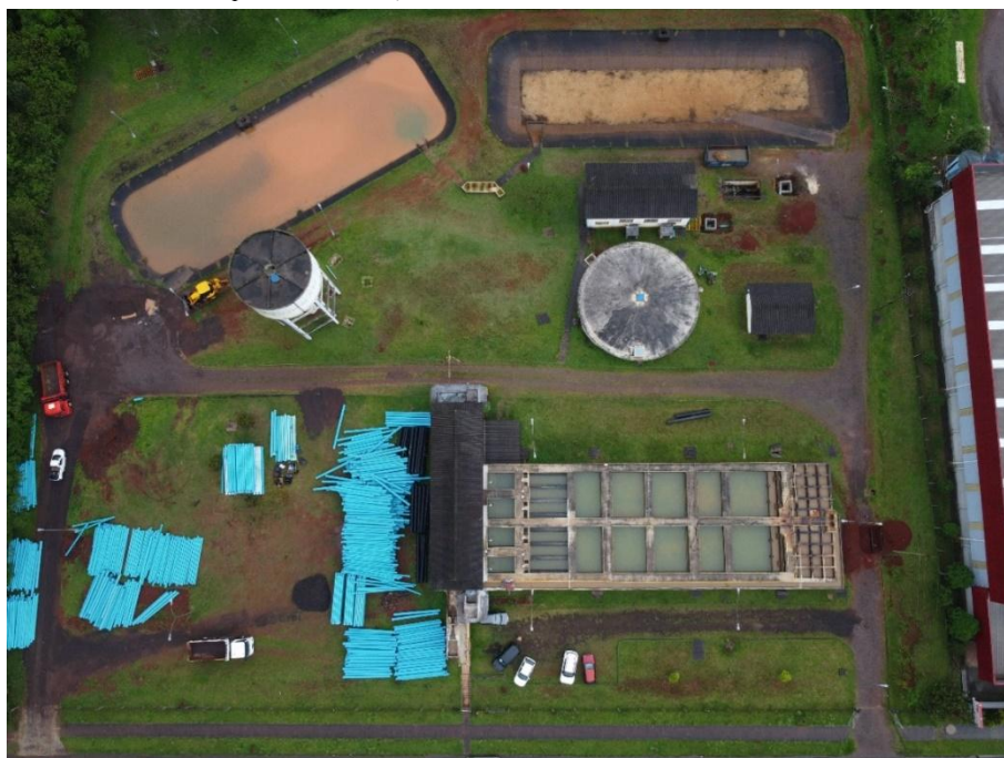
Figura 24 - Estação de Tratamento de Água ETA 2 2/2.
