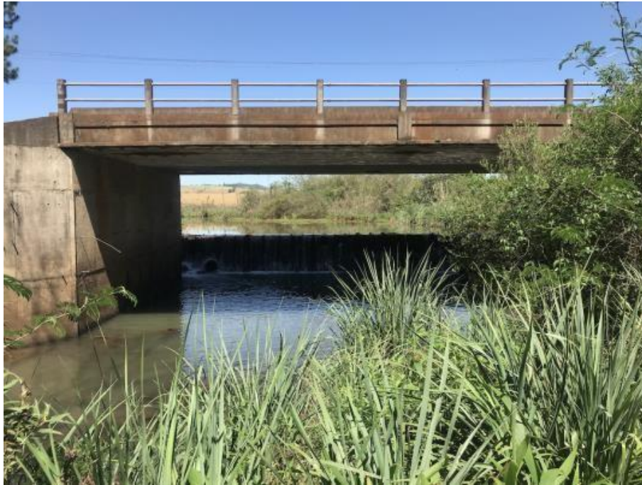
Figura 9 - Barragem (Rio do Campo).
